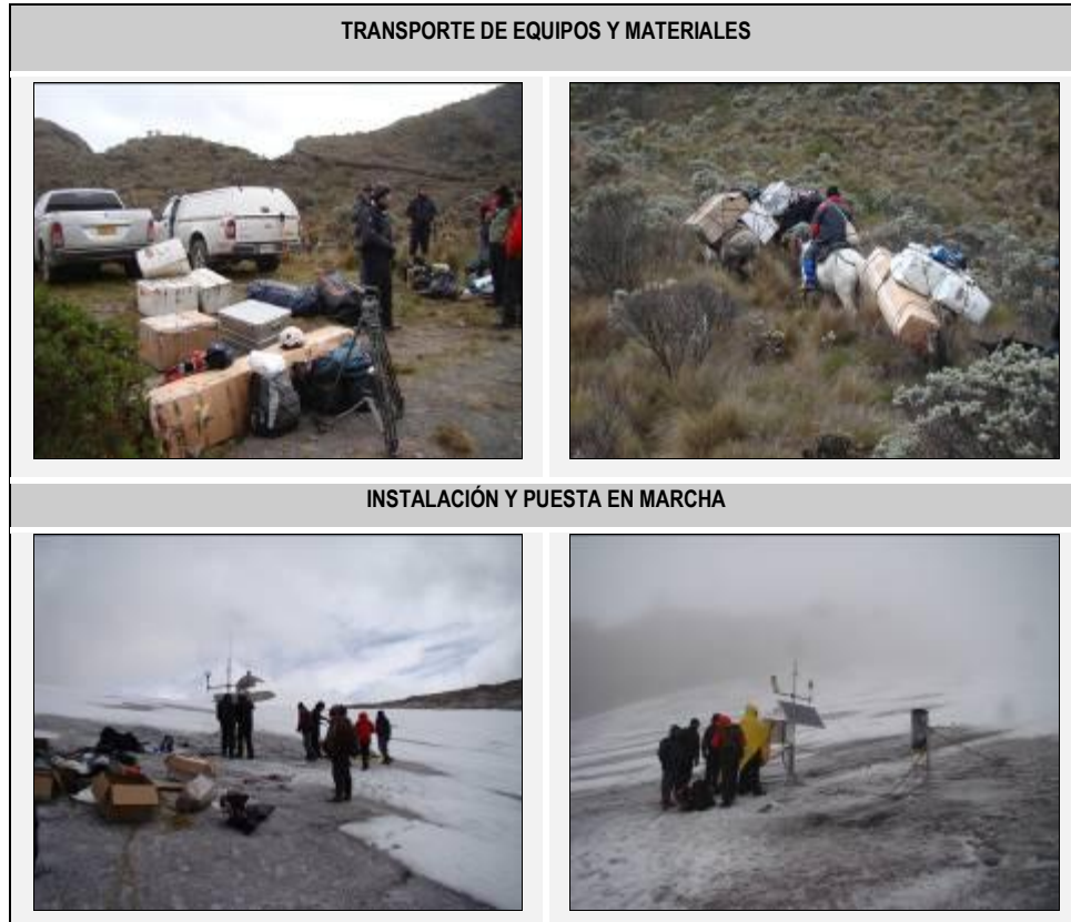
Figura 76. Proceso de instalación de la EMMA. Fotografías Jorge Ceballos.
